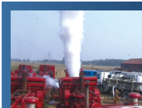
淮北矿区芦岭井田 WGL03 井压裂施工现场
