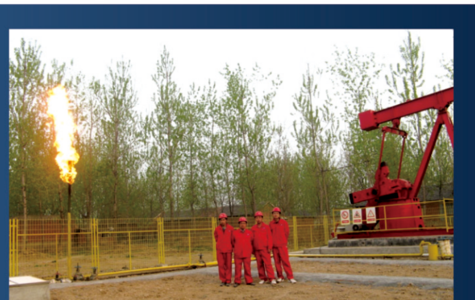
淮北矿区芦岭井田 WGL05 井排采现场
