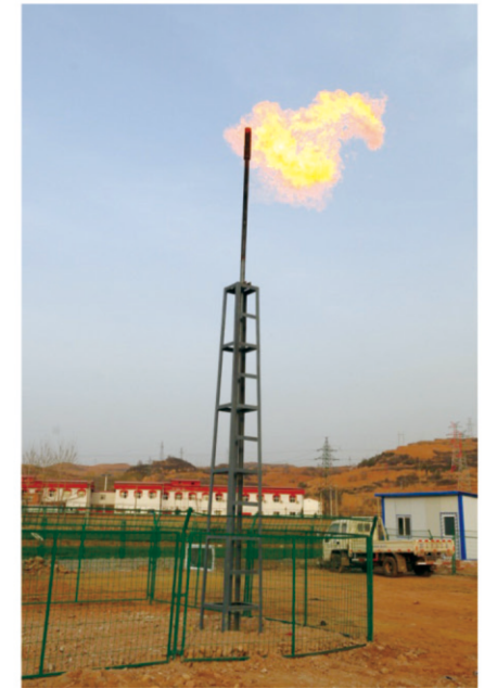
晋煤潘庄 SHU2 L型水平对接井排采现场
